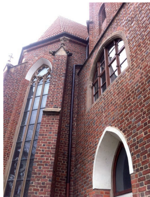
FOT. Budynek kościoła pw. św. Macieja we Wrocławiu, przy pl. Nankiera 17a, gdzie została zastosowana technologia bezinwazyjnego systemu osuszania Aquapol
